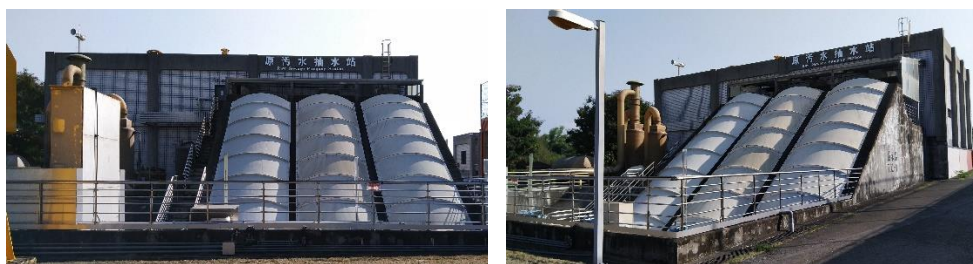
圖 2 原污水螺旋泵(以福田廠為例)
