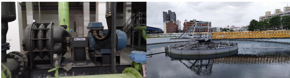
圖 4 多段離心式鼓風機及圓型刮泥機(以福田廠為例)
